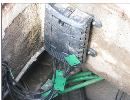
Figure 8 : Point d'aboutement situé dans une chambre
