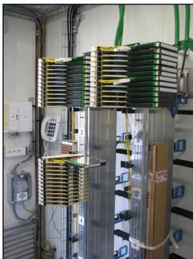
Figure 14 : Exemple de fermes optiques à l'intérieur d'un NRO accueillant les têtes de câbles du réseau de desserte
